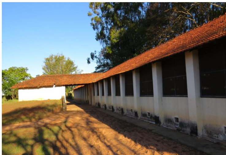
Figura 2. Sirgaria em alvenaria
