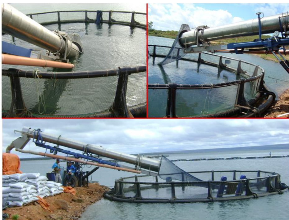
Figura 1. Tanque rede de 240 m 3 conjugado com equipamento para despesca mecanizada.
