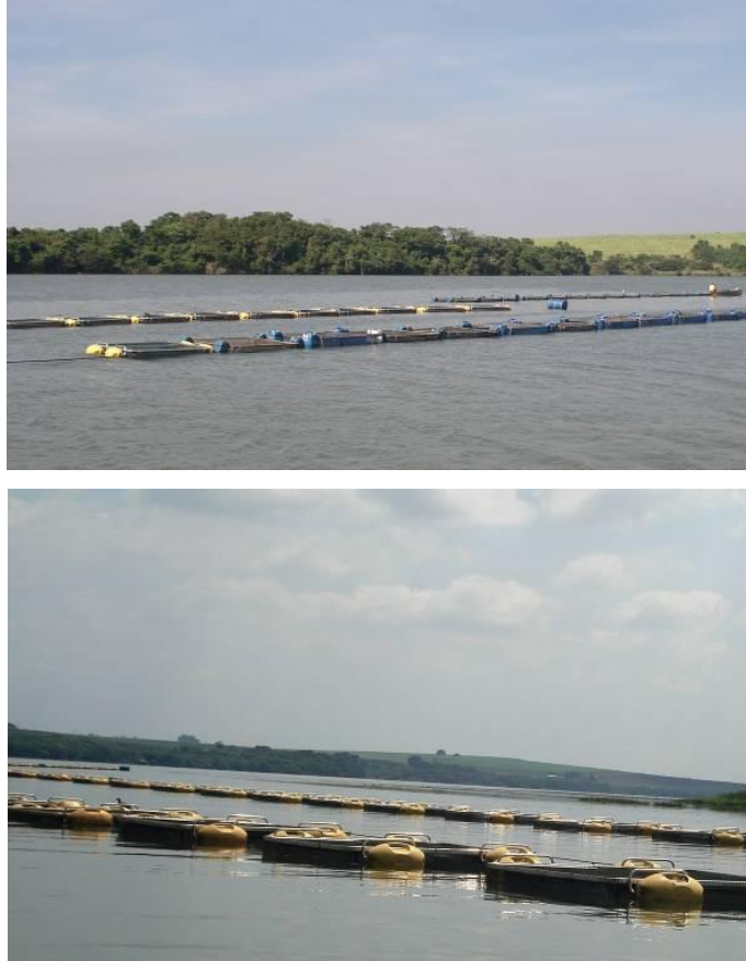
Figura 2. Sistemas de flutuação dos tanques-redes instalados na UHE Canoas II, SP. Fonte: Rezende-Ayroza et al. (2013).
