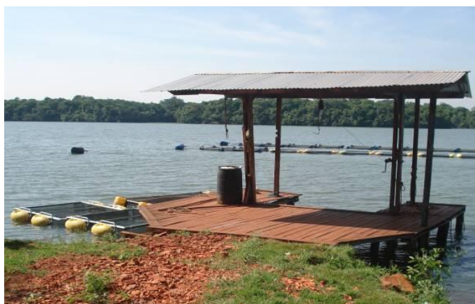
Figura 3. Píer para apoio dos barcos e recebimento dos tanques-rede para manejo da piscicultura. Fonte: Rezende-Ayroza et al. (2013).
